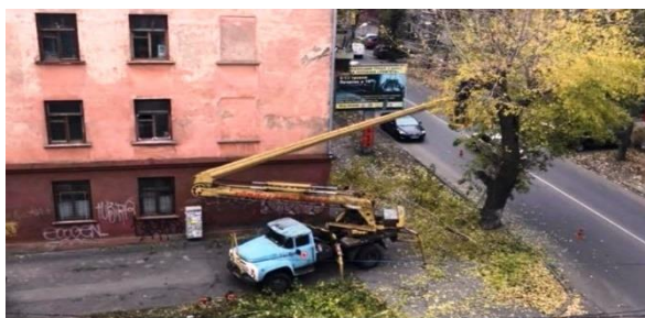
Рис. 12 Процес ремонту та утеплення будівлі у смт. Сартана
